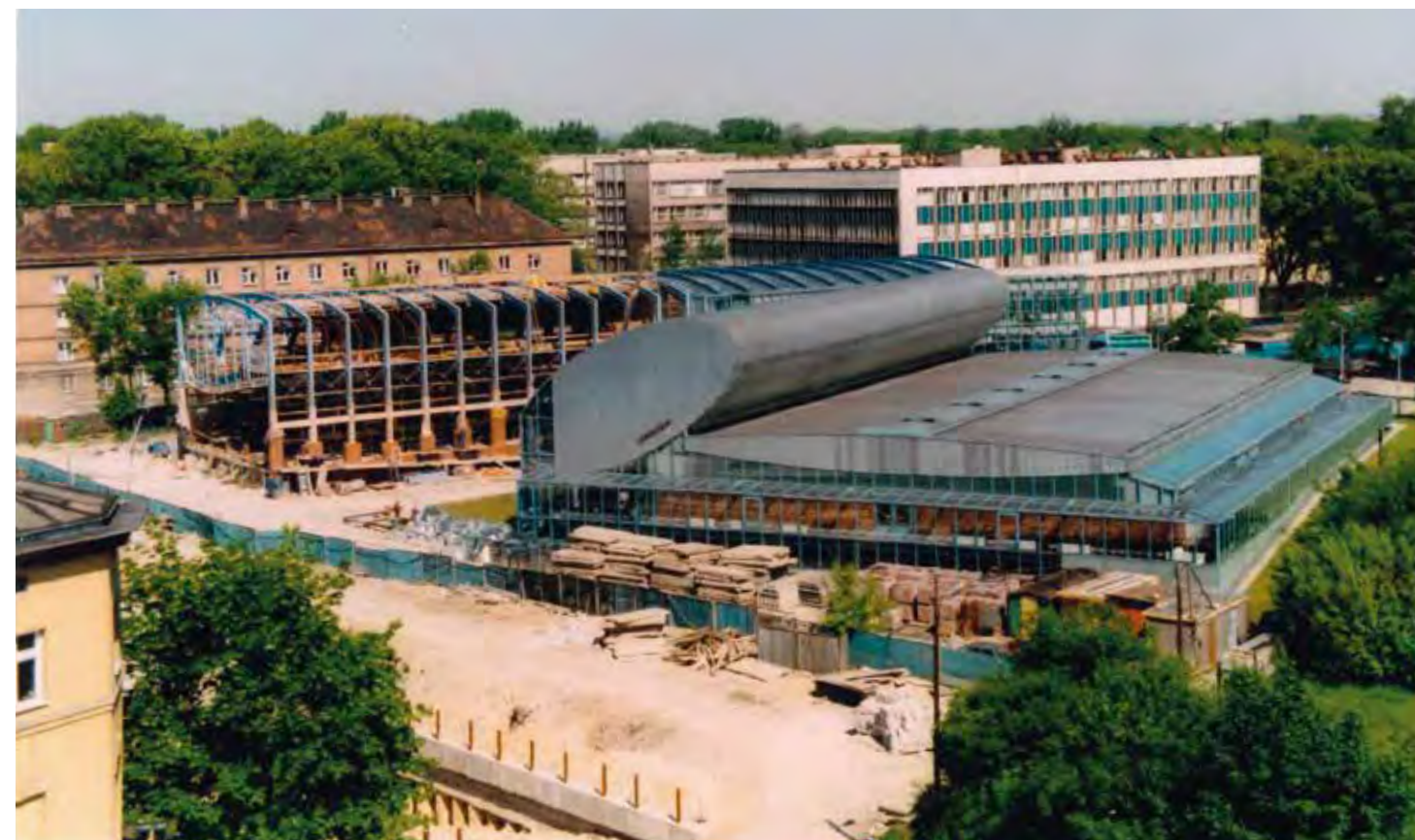
Budowa Pawilonu Sportowo-Dydaktycznego
